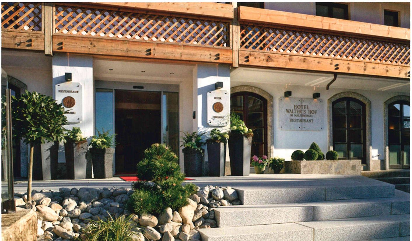
▲ Um den Gästen einen geschützten und komfortablen Zugang zum Hotel zu gewährleisten, wurde ein Windfang realisiert
